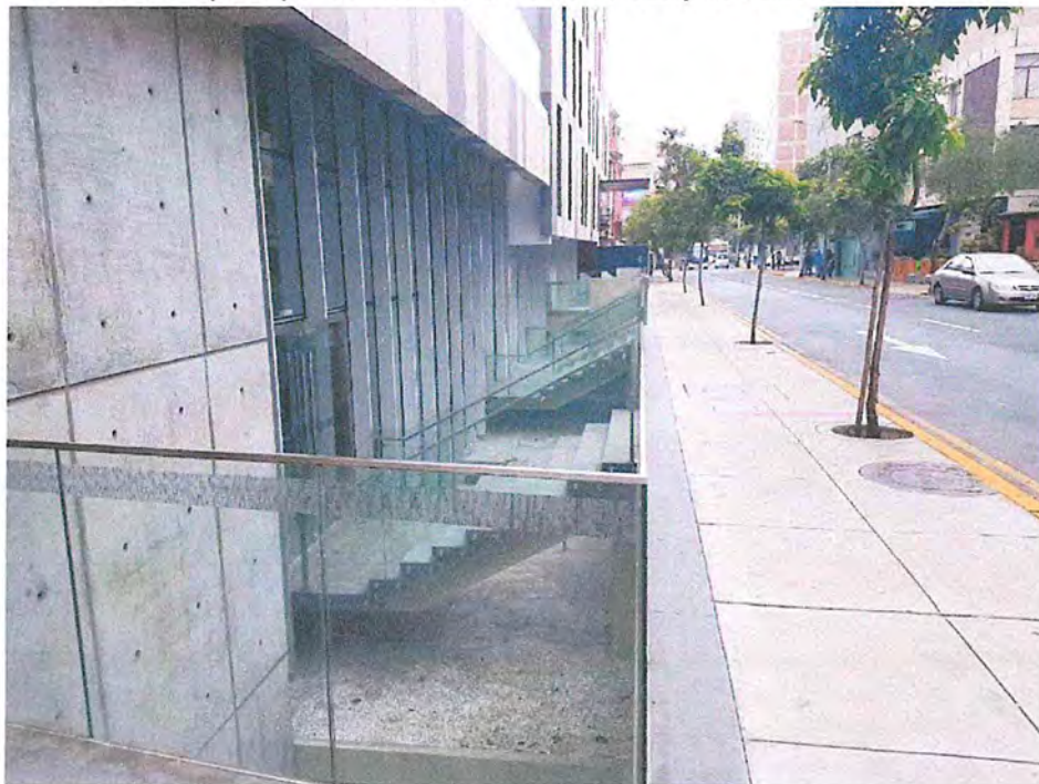
Foto: Retiro ocupado por semisótano a filo de vereda y voladizo en Av. Diez Canseco.
