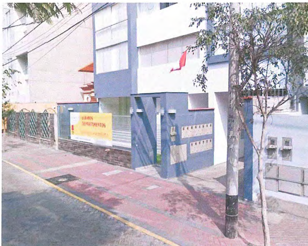
Foto: Retiro ocupado por cerco, terrazas privadas y voladizo en calle Schell.
