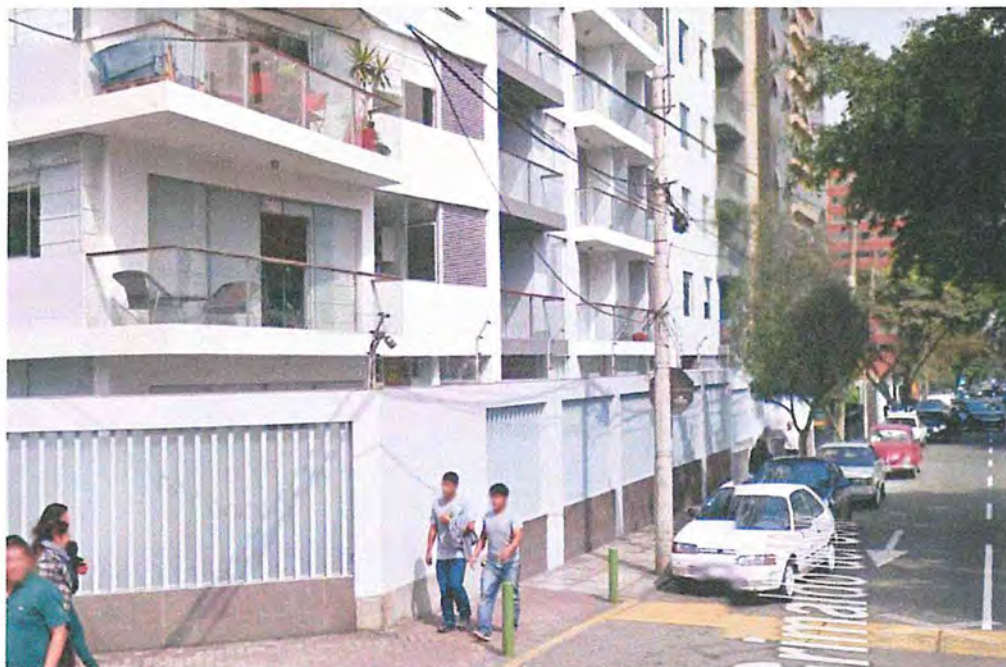
Foto: Retiro ocupado por cerco, terrazas privadas y voladizo en calle Grimaldo del solar.
