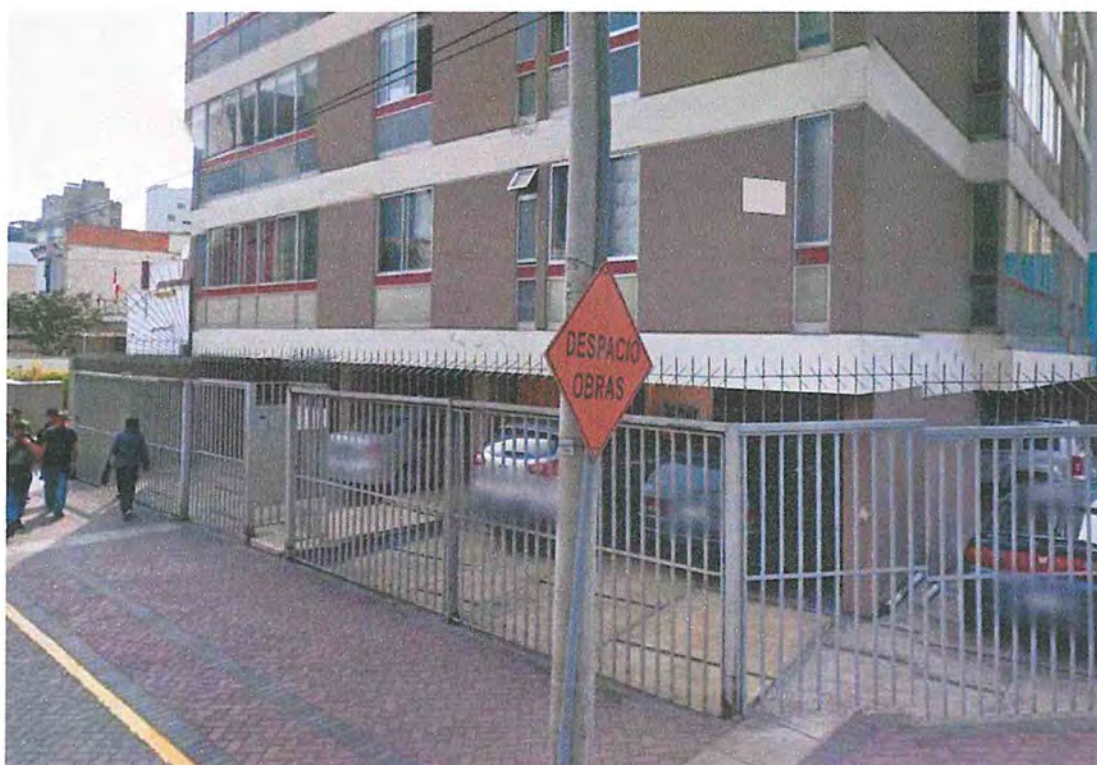
Foto: Retiro ocupado por cerco, estacionamientos (unidades inmobiliarias) y voladizo en calle Schell
