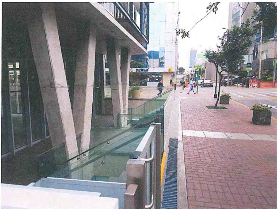
Foto: Retiro ocupado por semisótano a filo de vereda y voladizo en Av. La Paz.
