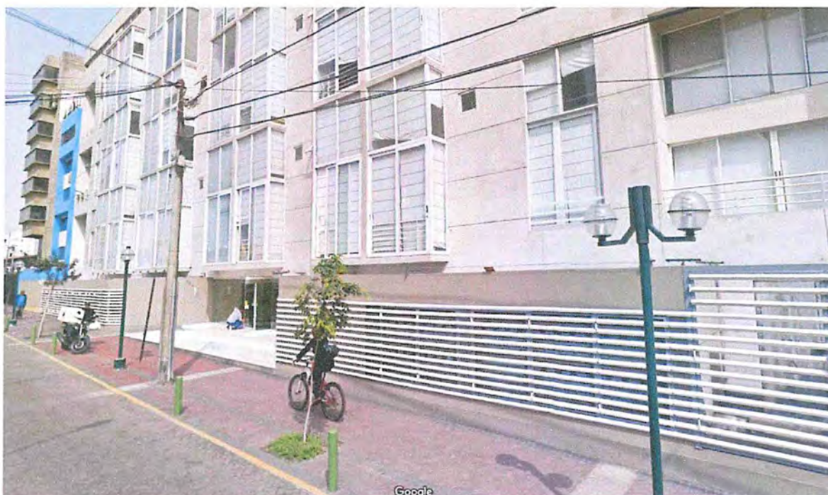
Foto: Retiro ocupado por cerco, terrazas privadas y voladizo en calle Schell
