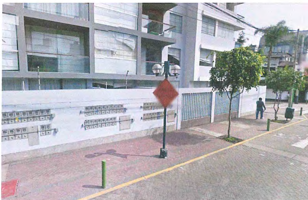
Foto: Retiro ocupado por cerco, terrazas privadas y voladizo en calle Schell.
