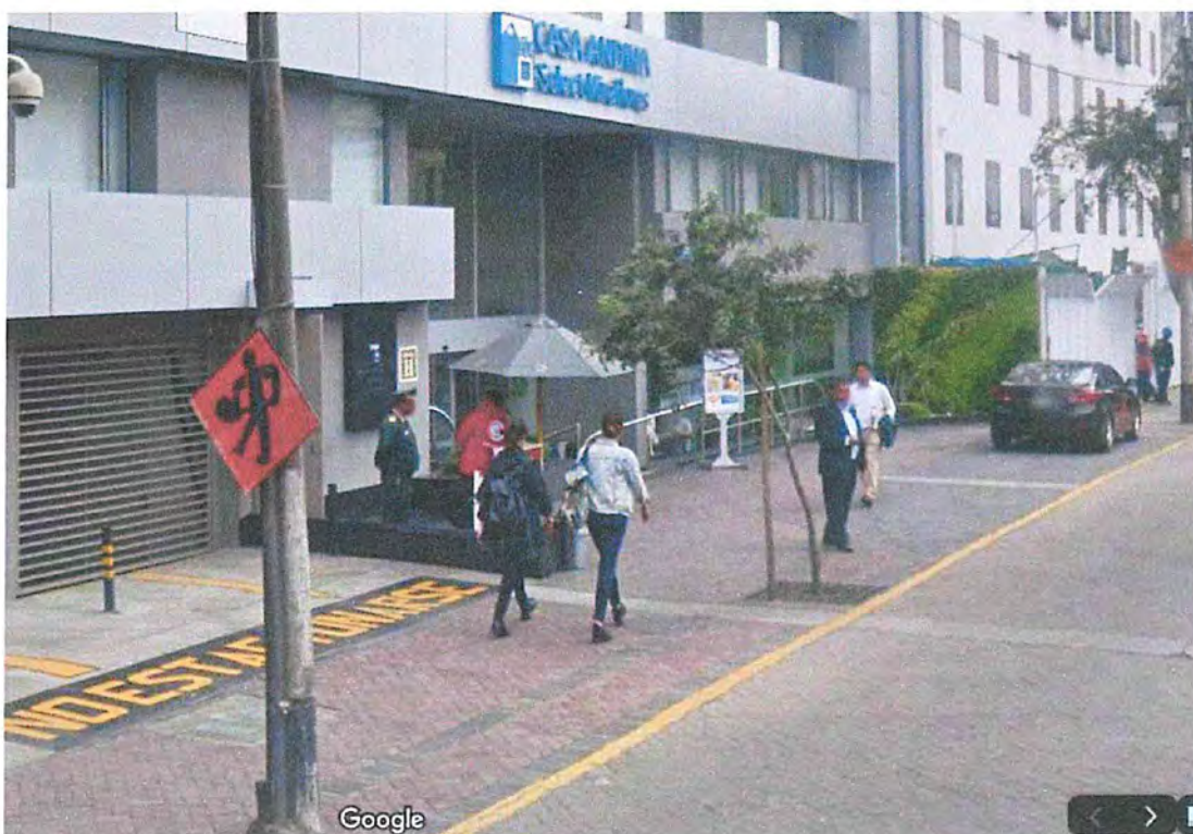
Foto: Retiro ocupado por voladizo en la calle Schell.
